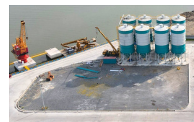
GGBS Silos Kho chứa xỉ lò cao
