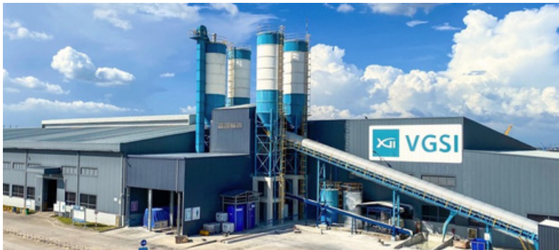
Factory / Nhà máy
