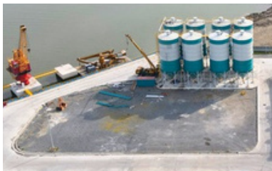
GGBS Silos Hệ thống Silo GGBS
